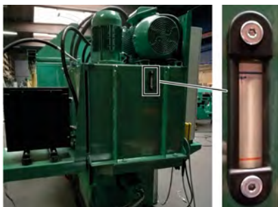
Fig. 15: Réservoir d'huile hydraulique avec jauge de niveau
