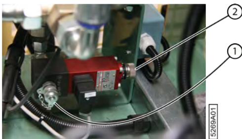
Fig. 51: Du poste de travail gauche
